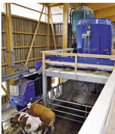
Der stationäre 12 m<sup>3</sup> Mischer befindet sich im Obergeschoss. So konnte platzsparend gebaut werden. Den Kühen steht dadurch mehr Platz zur Verfügung.
