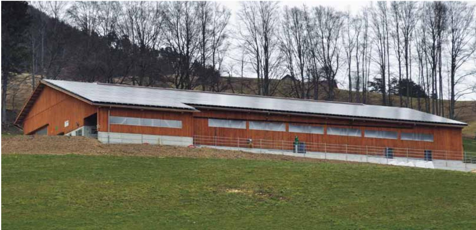
Zwischen den Solarpanels und dem Dach wird die warme Luft für die Heubelüftung erzeugt und angesogen.
