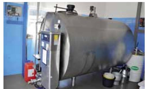
FCC milchflussgesteuerte Kühlung: Dieses einmalige Kühlsystem für den VMS von DeLaval basiert auf dem patentierten Prinzip der milchflussgesteuerten Kühlung.
